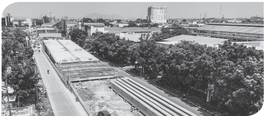
PEMBANGUNAN JEMBATAN LAYANG DI BANDUNG
